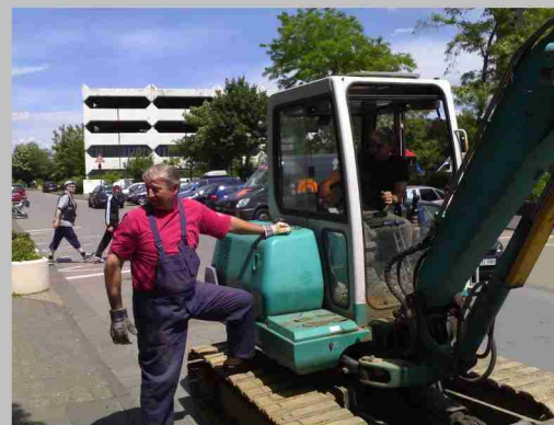
Von Hand allein geht es nicht. Die Baumaschinen rücken an.
