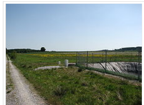
Drainage der mit perfluorierten Tensiden belasteten Fläche bei Scharfenberg
